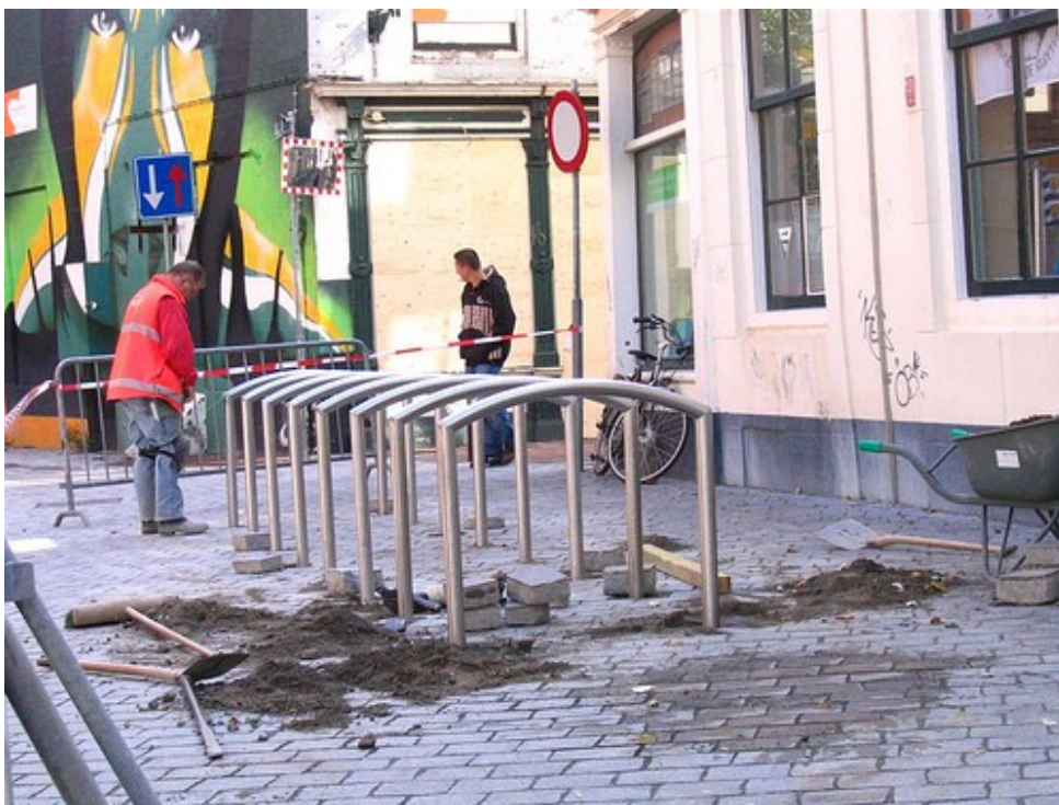
Монтаж новой велопарковки в центре Брюсселя
